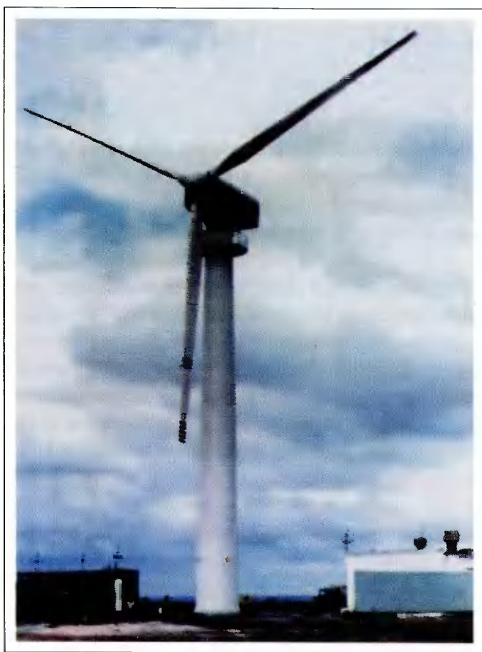
Рис. 15. Ветроэнергетическая установка “Радуга-1” мощностью 1000 кВт на Калмыцкой ВЭС
