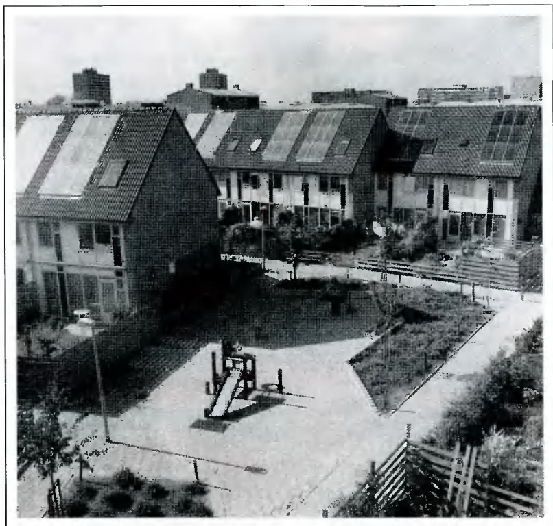
Рис. 11. Использование солнечных коллекторов для горячего водоснабжения жилых домов
