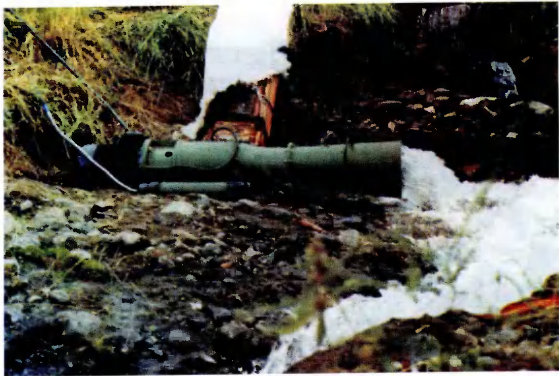
Рис. 18. МикроГЭС мощностью 10 кВт, Республика Тыва
